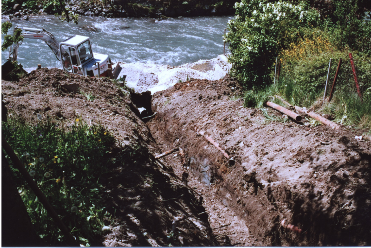
Abb. 10) Entwässerungsgräben zur Sill
