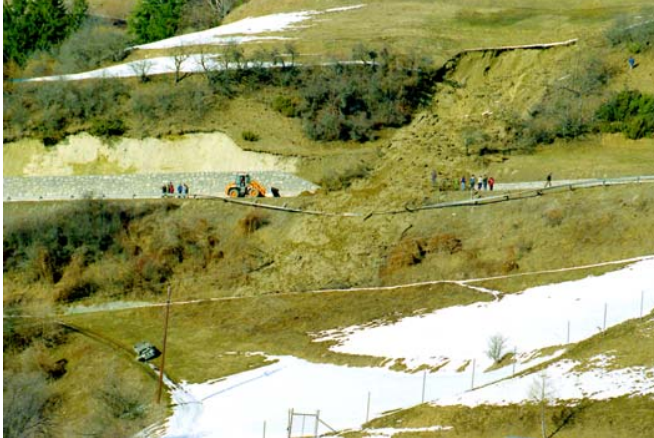
Foto 3: Hangexplosion als Beispiel für plötzliche Hangerosions- bzw. Hangbewegungsprozesse. Der PKW wurde durch den plötzlichen Erosionsprozess in die Tiefe geschleudert (nahe dem linken unteren Bildrand).
