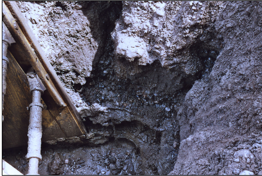
Abb. 13) Dünne Schluffschichten zwischen durchlässigen Kiesschichten
