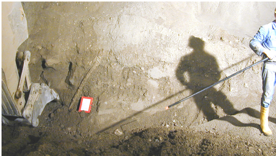
Abb. 7: Foto einer Störung in den Terrassenschottern bei TM 304,7 im Vortrieb Terfens.
