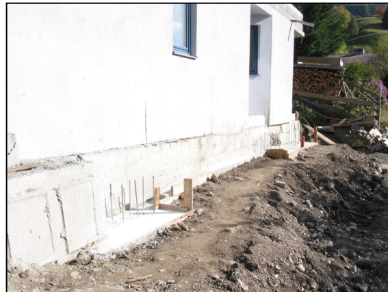
Abb. 24) Nach der Herstellung des Fundamentbalkens
