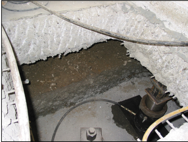
Abb. 21) Gehobenes Innenfundament
