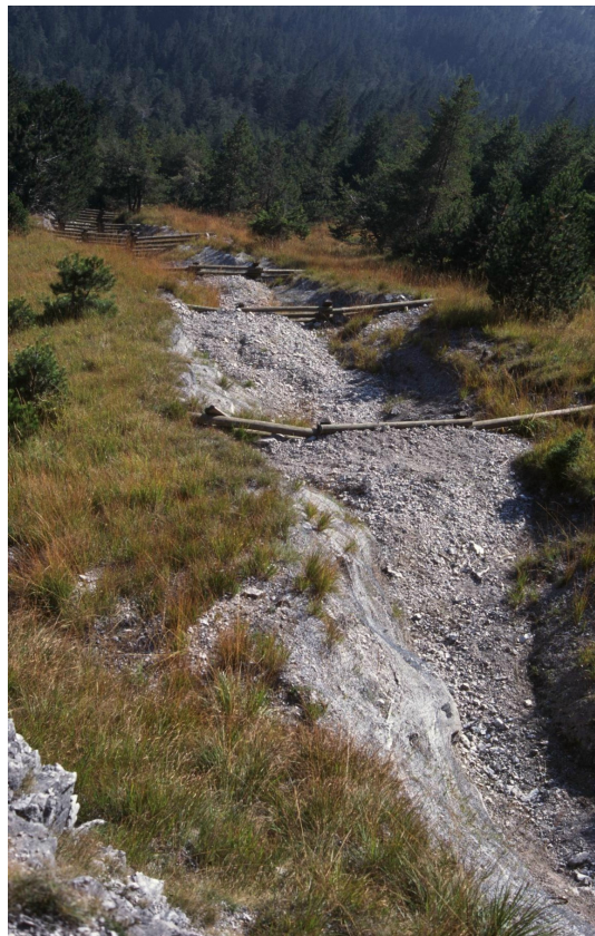
Bild 5: Absam – die Runse ist verbaut – die Gefahr gebannt
