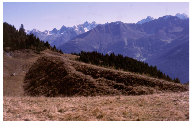
Lawinendamm mit Böschungsbruch
