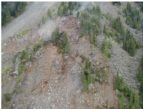
Bild 2: Anrisszone – Versetzungsbeträge von mehreren Metern nach wenigen Tagen
