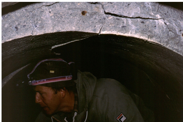
Rohrdurchlass unterer Lawinendamm
