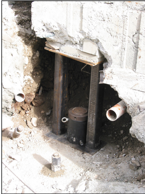
Abb. 17) Außenfundament
