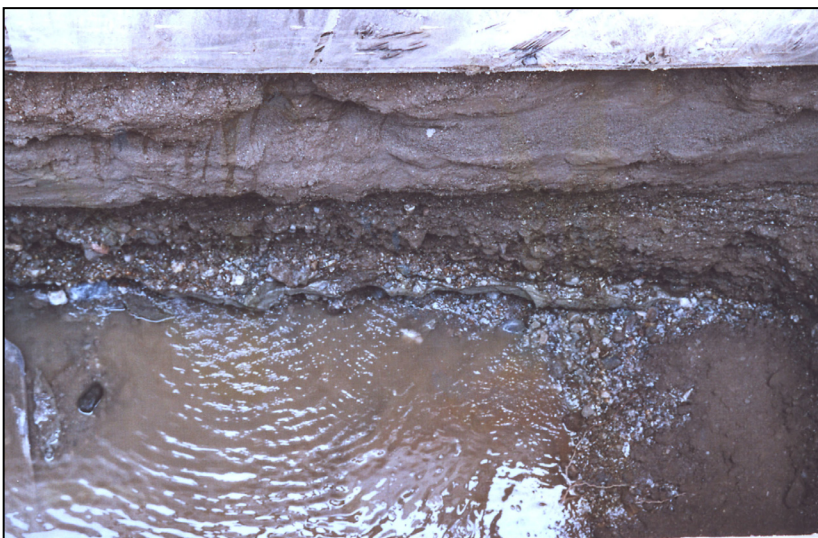
Abb. 12) Große Wasseraustritte oberhalb der Schluffschichten
