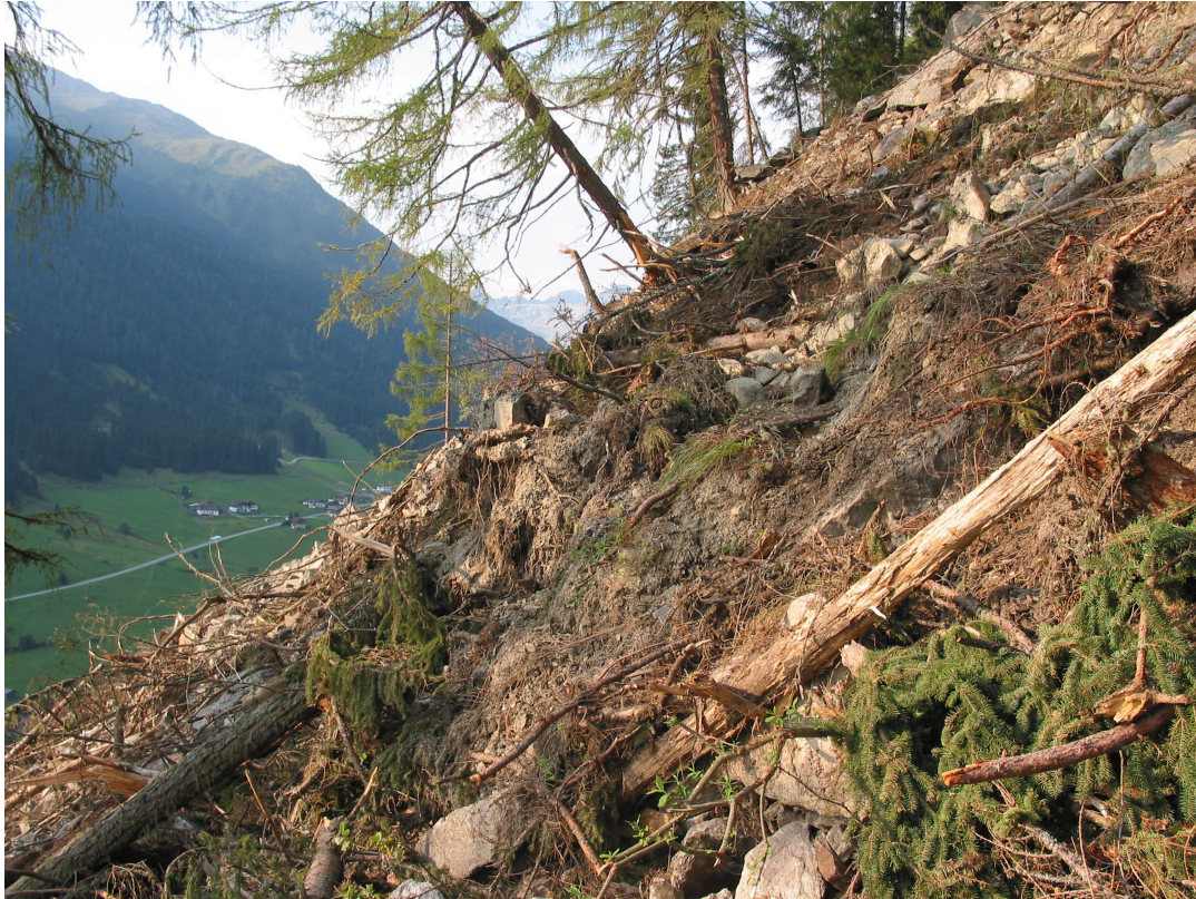
Abbildung 14: Stirn der Massenbewegung mit übersteiler Böschung
