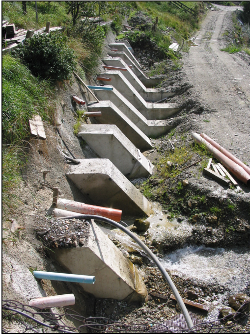
Abb. 14) Ortbetonbalken oberhalb der Pfahlköpfe
