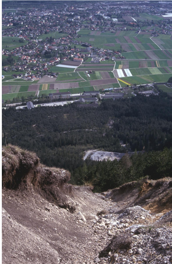
Bild 4: Absam – tiefe den Lebensraum bedrohende Runsen - Erosion nach einem Waldbrand
