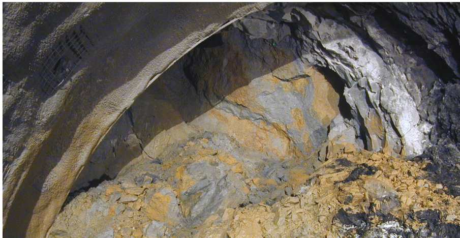
Abb. 5: Gesteine der Raibler Schichten (Tonstein, Dolomit, Anhydrit Gips, Rauhwacken) mit einem Karstschlot in den Evaporiten, der mit braunen Dolomitsanden verfüllt war. Foto bei TM 667,3 im Vortrieb Vomp Ost.
