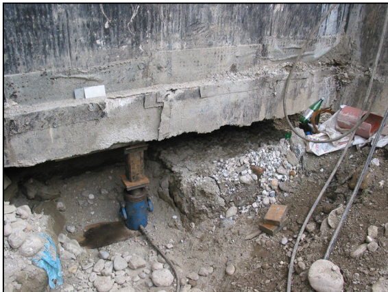
Abb. 23) Vor der Herstellung des Fundamentbalkens
