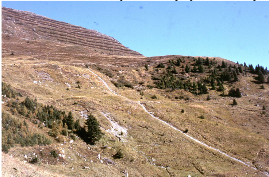
Fließmanteldränage im Einhang zum Fallboden – gr. Lawinenschutzdamm
