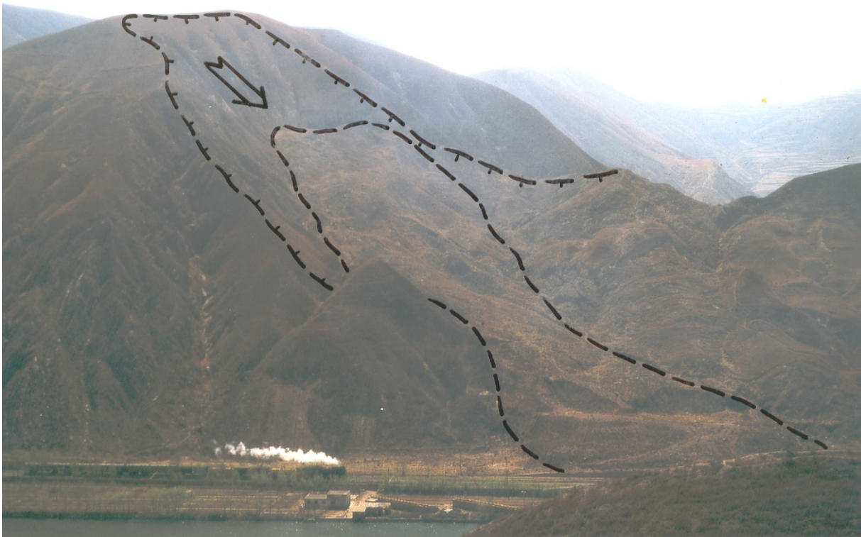
Abb. 8: Rutschbereich im Löss hinter dem Ta Pan Xia- Damm westlich von Lanzhou, dessen Akkumulationsbereich die Eisenbahnstrecke von Lanzhou nach Xining (geplant bis Lhasa) vernichtete (Foto: J. Weidinger, 1997).
