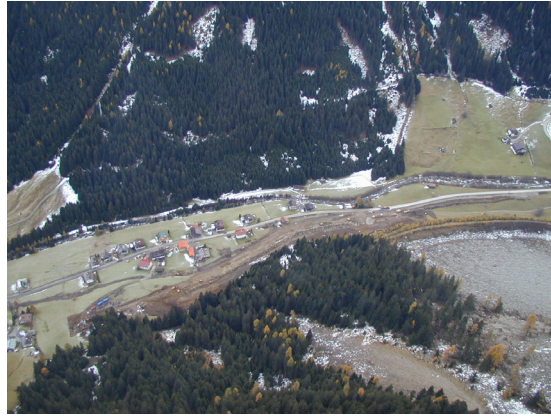
Bild 7: Schutzdamm für die Straße aus dem Jahr 1980 (rechts) und Baustelle für den neuen Damm (links) aus der Hubschrauberperspektive.
